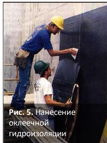
Рис. 5. Нанесение оклеечной гидроизоляции
