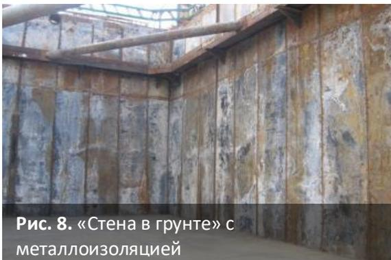
Рис. 8. «Стена в грунте» с металлоизоляцией
