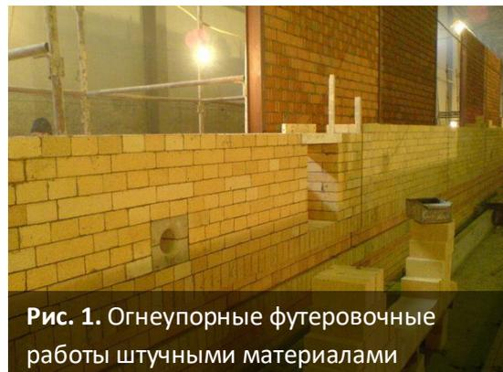
Рис. 1. Огнеупорные футеровочные работы штучными материалами
