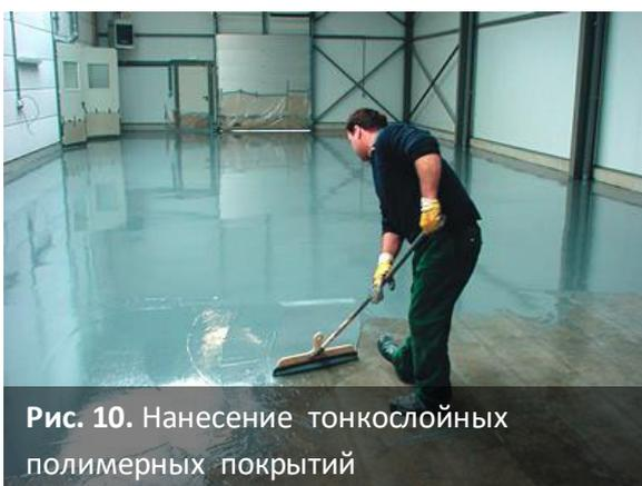
Рис. 10. Нанесение тонкослойных полимерных покрытий
