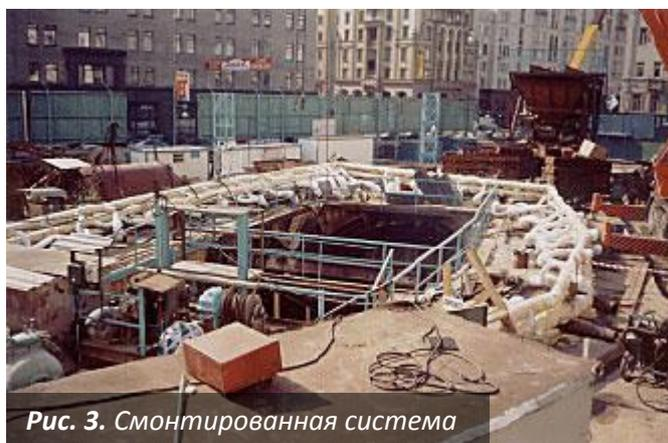
хладоагента испытывают систему в целом сжатым воздухом под давлением 1,2 МПа для всасывающей и 1,8 МПа для нагнетательной стороны. Монтаж системы считается выполненным, если в течение первых 6 ч давление в системе снижается не более чем на 10 %, а в течение остального времени остается постоянным.
