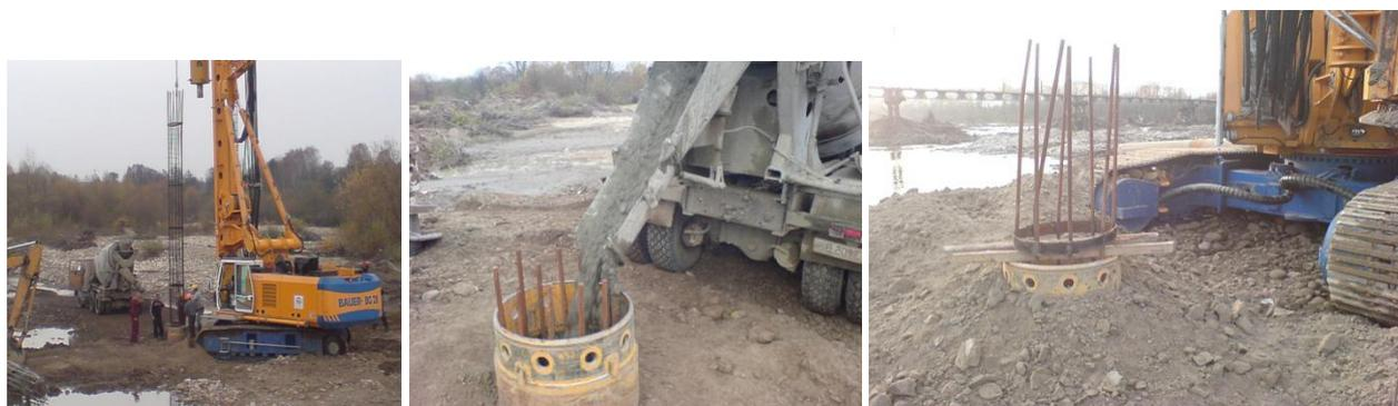
*Рис. 7. Установка арматурного каркаса*
