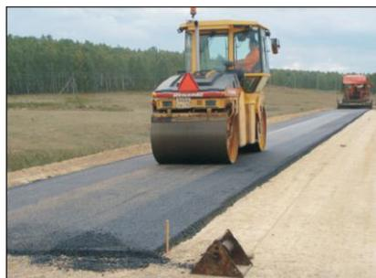
Стабилизирующая добавка «Консолид 444» представляет собой жидкость желтого цвета, при производстве работ растворяемая в воде в соотношении 1:4. Стабилизирующая добавка «Слидрай» – смесь катионных поверхностно-активных веществ, представляет собой серый порошок с запахом аммиака, полностью гидрофобный и нерастворимый в воде. Хранение смеси не ограничено по срокам.
