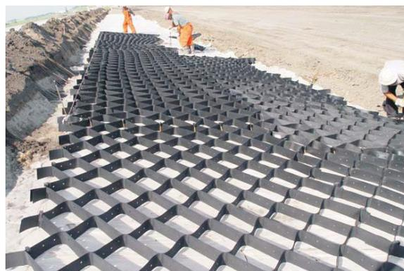
Соединение соседних модулей происходит за счет скрепления стенок примыкающих друг к другу ячеек с помощью пневмостеплера или их общей анкеровки. Производится заполнение ячеек щебнем. Щебень равномерно распределяется в ячейки механизированным способом или вручную, сверху вниз по откосу.
