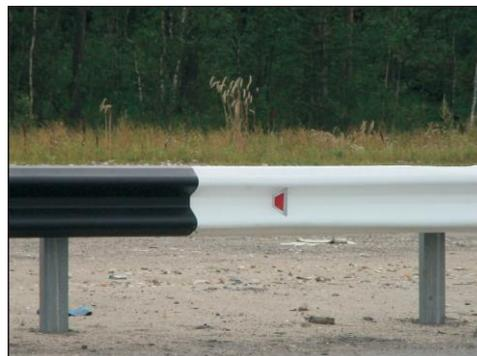
Рассматриваемая технология содержит требования к защитным пластиковым панелям, а также правила их установки и эксплуатации. Монтаж защитных пластиковых панелей следует производить после установки металлического барьерного ограждения. Для монтажа защитных пластиковых панелей разборку металлического основания ограждений производить не требуется.
