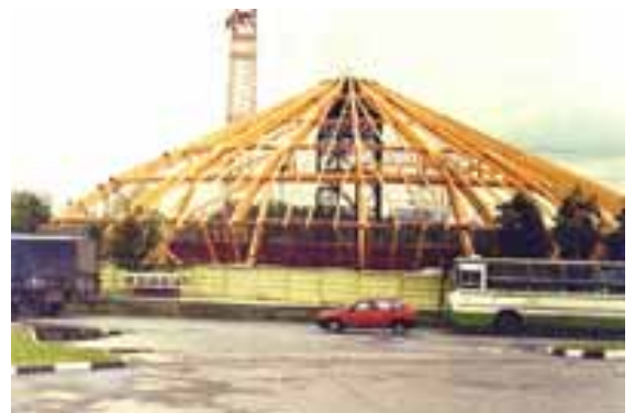
Рис. 9. Склад для хранения противогололедных реагентов с купольным конструктивным решением в процессе строительства (Москва)
