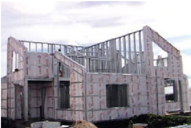
Рис. 4. Двухэтажный коттедж: а - монтаж каркаса из холодногнутых профилей; б - общий вид готового здания
