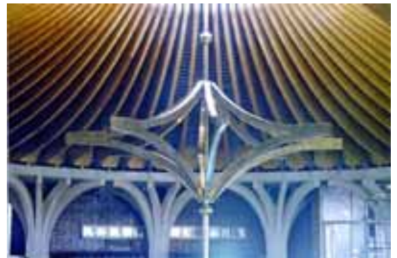
Рис. 8. Клееные конструкции общественного центра «Липки» в Московской области
