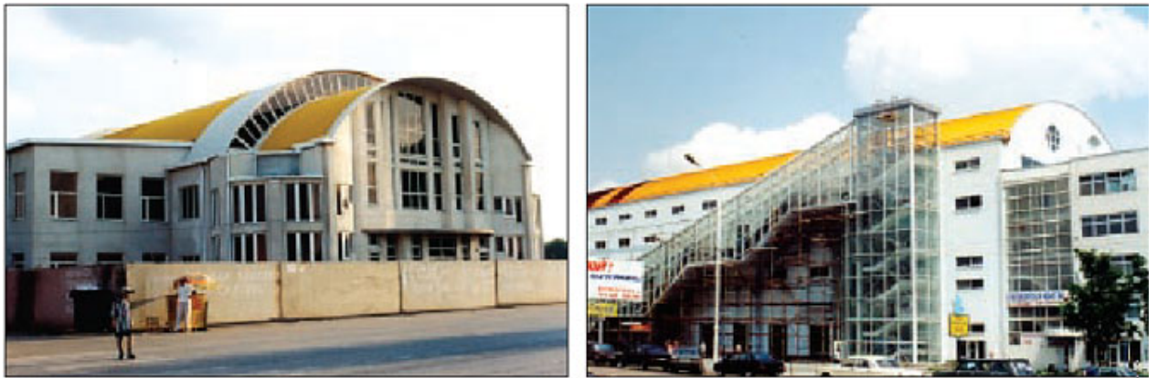
Рис.5. Здания с бескаркасным арочным покрытием: а - спортивный комплекс пролетом 25 м; б - торговый центр пролетом 20 м
