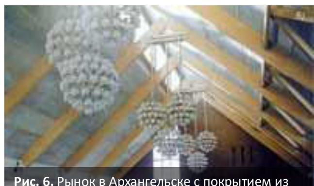
Рис. 6. Рынок в Архангельске с покрытием из клееных конструкций
