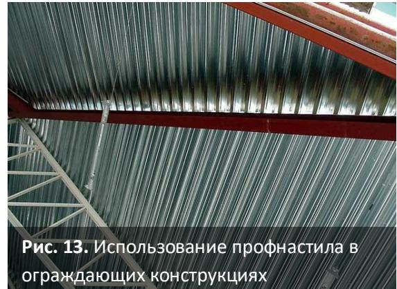
Рис. 13. Использование профнастила в ограждающих конструкциях
