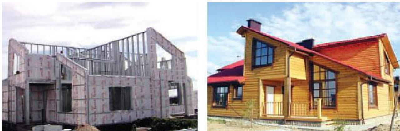
**Рис. 4.** Двухэтажный коттедж: а - монтаж каркаса из холодногнутых профилей; б - общий вид готового здания
