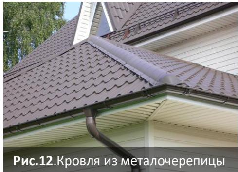
Рис.12.Кровля из металличерепицы
