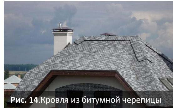
Рис. 14. Кровля из битумной черепицы
