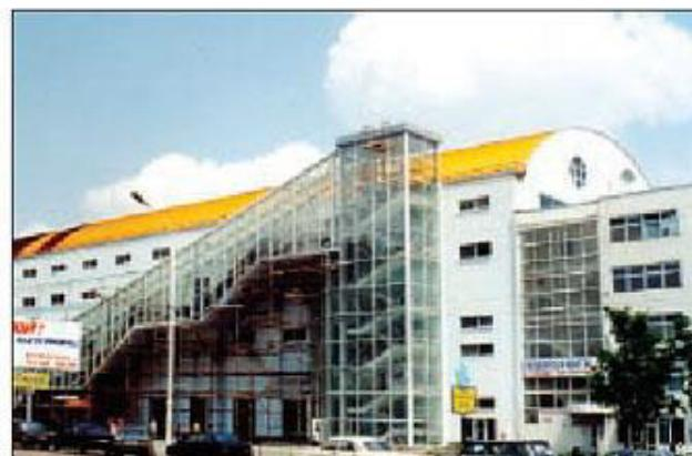
Рис.5. Здания с бескаркасным арочным покрытием: а - спортивный комплекс пролетом 25 м; б - торговый центр пролетом 20 м
