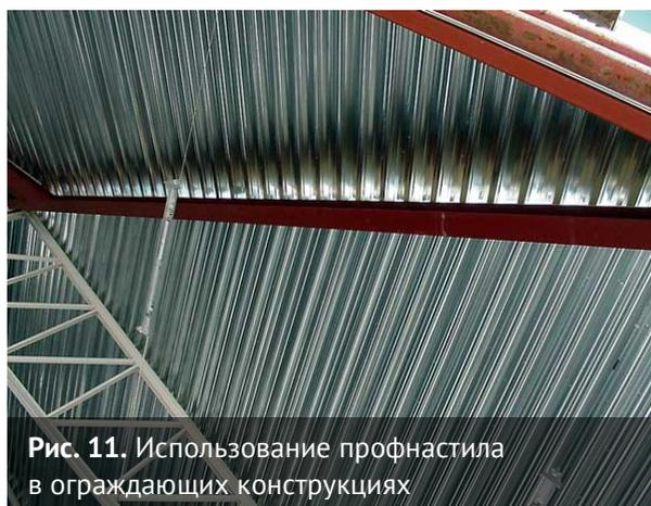
Рис. 11. Использование профнастила в ограждающих конструкциях
