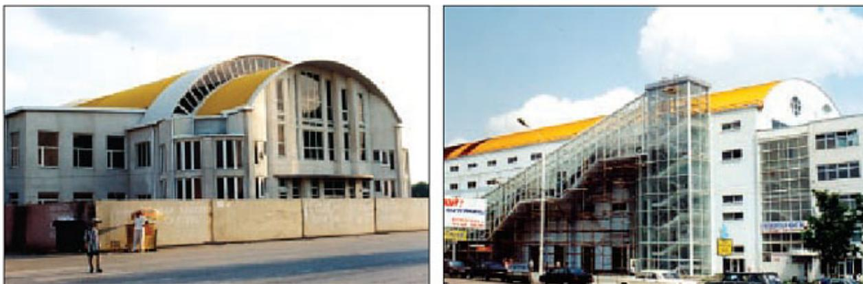
**Рис. 5.** Здания с бескаркасным арочным покрытием:
